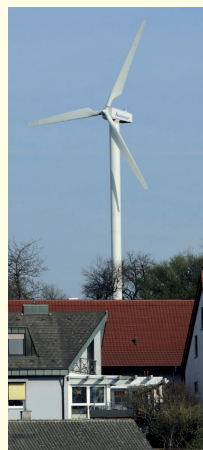
Auf ein verträgliches Nebeneinander von Windenergieanlagen und Wohngebäuden muss geachtet werden. Der Windenergieerlass Baden-Württemberg sieht für die Regionalplanung und die Flächennutzungsplanung einen Vorsorgeabstand von 700 m zwischen Windenergieanlagen und Wohngebieten vor. Abweichend davon können sich in der Einzelfallbetrachtung deutlich höhere, aber auch niedrigere Abstände ergeben.
