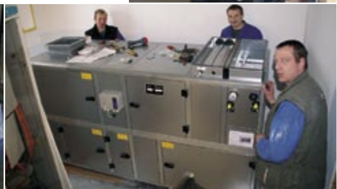
Montage der Lüftungsanlage
