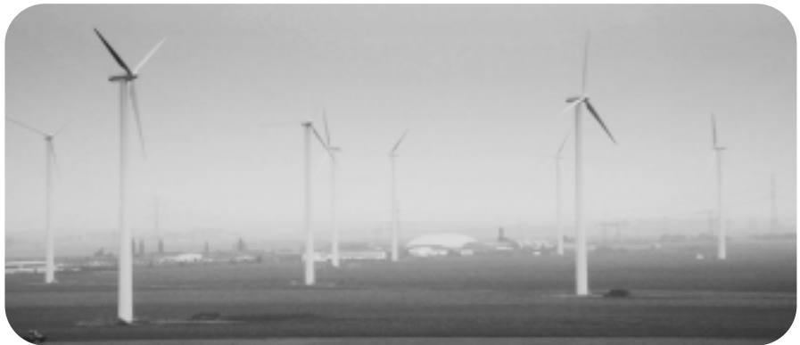
Der Windpark Glaubitz in der Errichtungsphase
